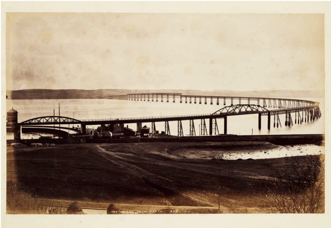
Abbildung 1. Ansicht der ersten Brücke über den Firth of Tay von Norden, Public domain, via Wikimedia Commons.
